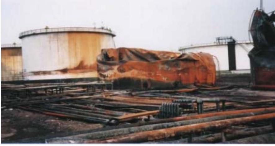
Şekil 9. Yangın Sonrası Çöken Tanklar
