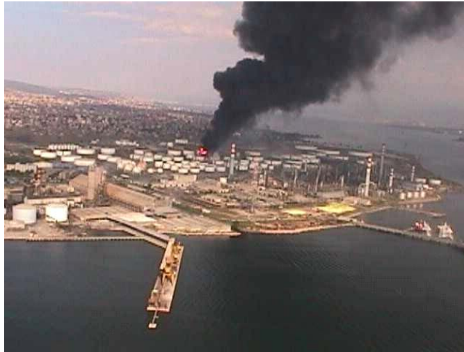
Şekil 7. Kocaeli Depremi Sonrası Tüpraş Rafinerisi
