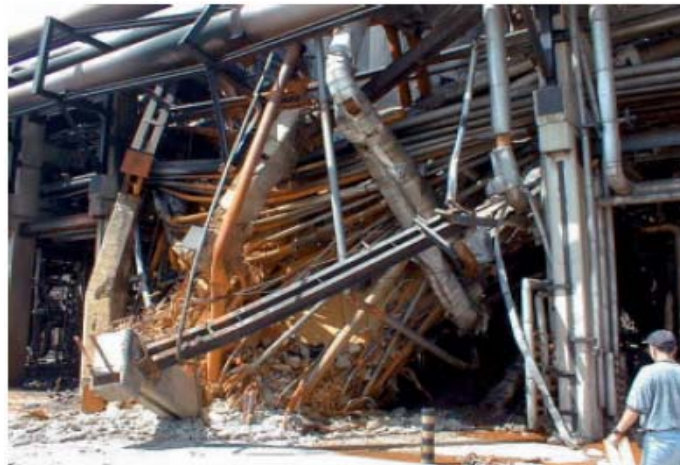
Şekil 10. Çöken Kule ve Hasar Gören İletim Boruları
