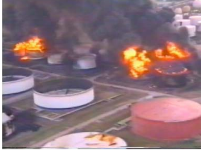
Şekil 8. Tanklarda Çıkan Yangınlar
