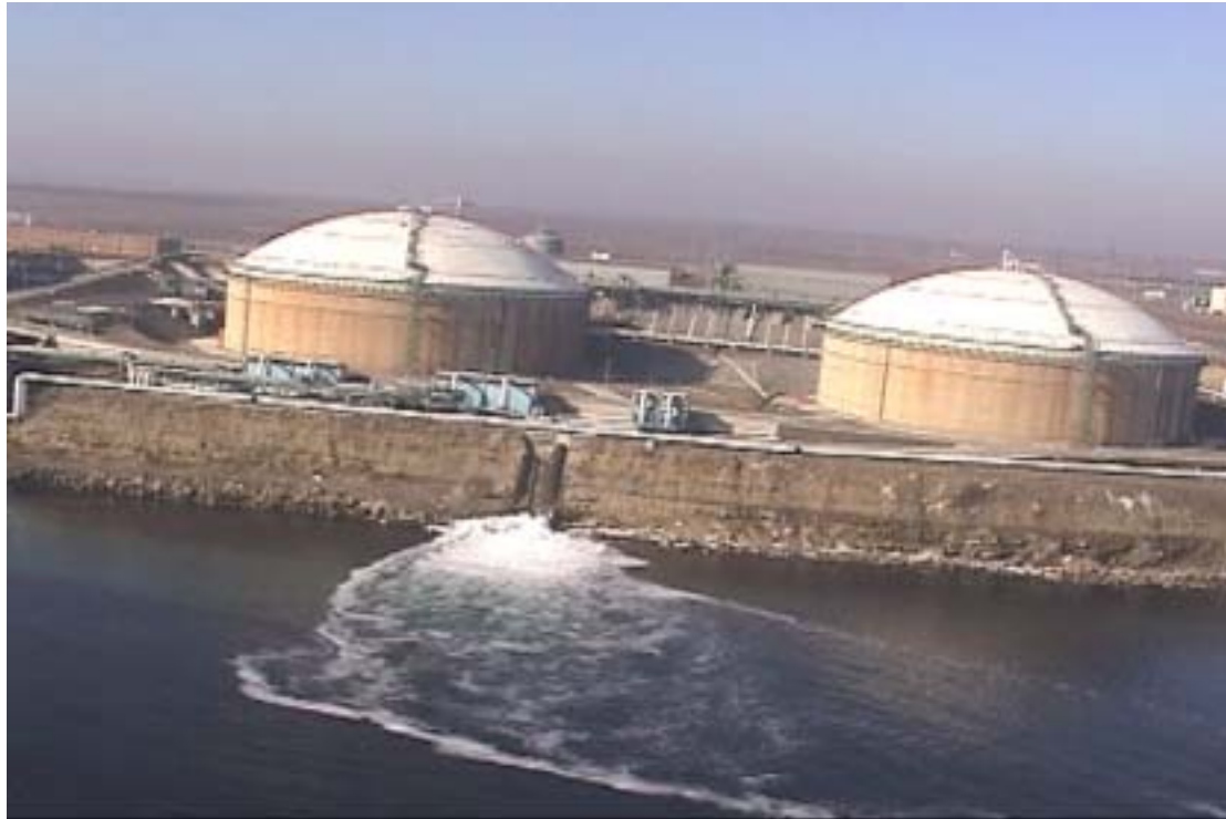
Figure 3.2.91. The LNG storage tanks and vaporized LNG distribution units.
