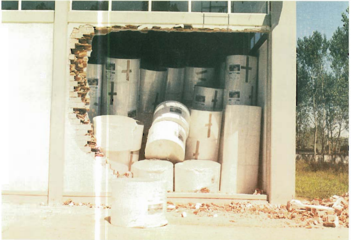
KARTON RULOLARIN DEVRİLMESİ İLE YIKILMIŞ DIŞ CEPHE DUVARI (KARTONSAN-KULLAR)
