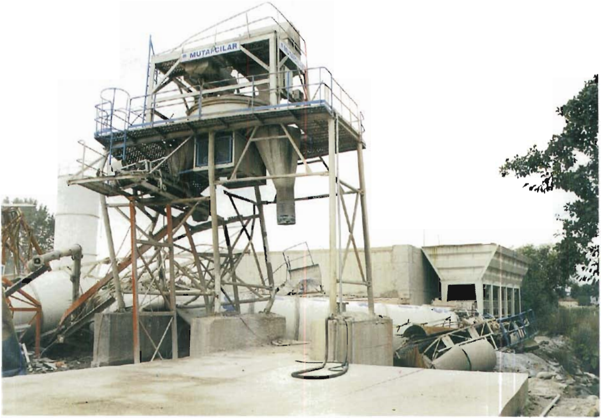
ÇİMENTO SİLOLARININ DEVRİLMESİ İLE AĞIR HASAR GÖRMÜŞ ÇELİK BORU AYAKLI BETON SANTRALİ
