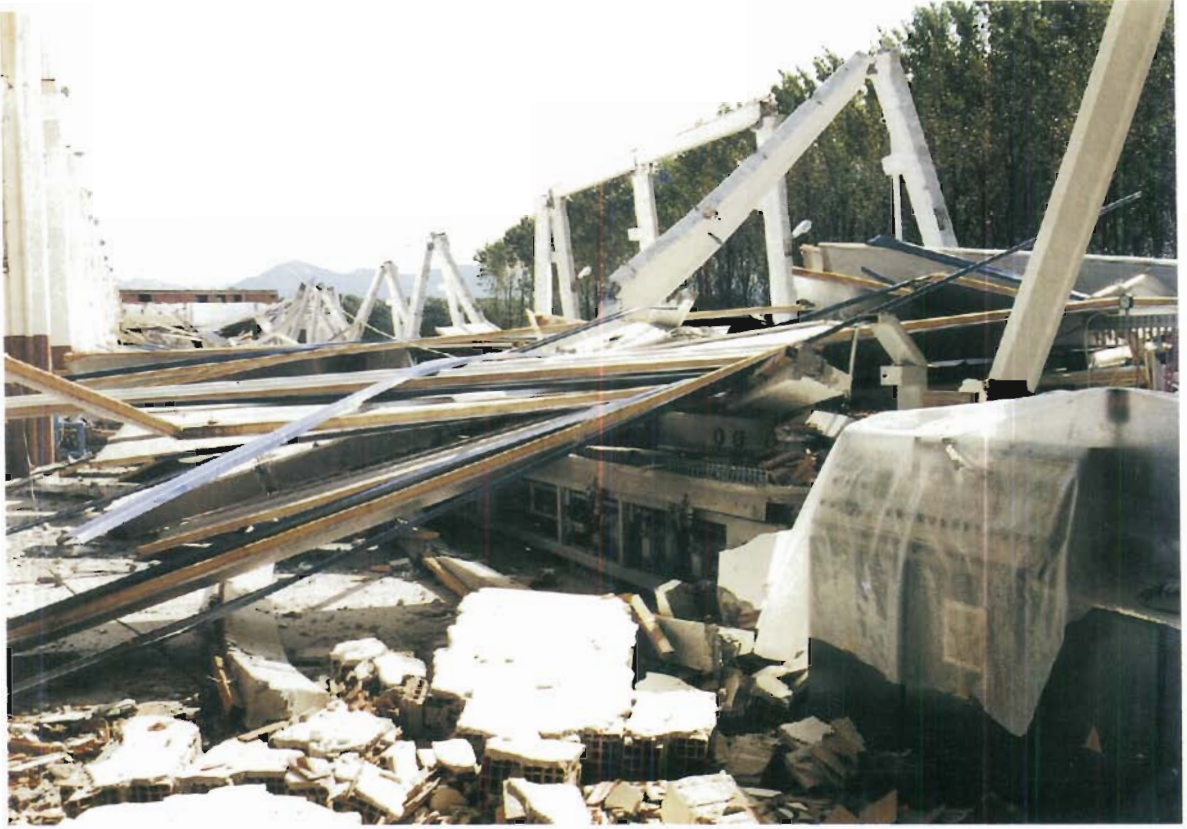
YIKILMIŞ BETONARME PREFABRİKE ÇERÇEVE ALTINDA HASAR GÖRMÜŞ TUĞLA FABRİKASI MAKİNALARI
