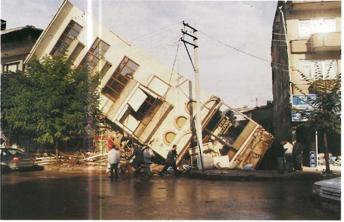
Adapazarı'nda sivilaşma nedeni ile taşıma gücünü yitirmiş zeminde yan yatan ve devrilen yapılar
