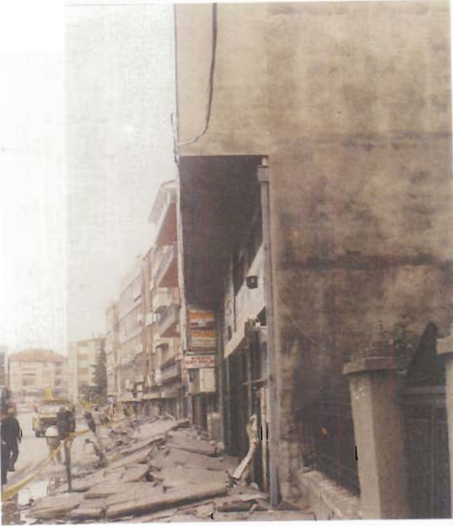
ADAPAZARI'NDA SIVILAŞMA NEDENİYLE TAŞIMA GÜCÜNÜ YİTİRMİŞ ZEMİNDE OTURAN YANINDAKİ ZEMİNİ YUKAR İTEN YAPILAR
