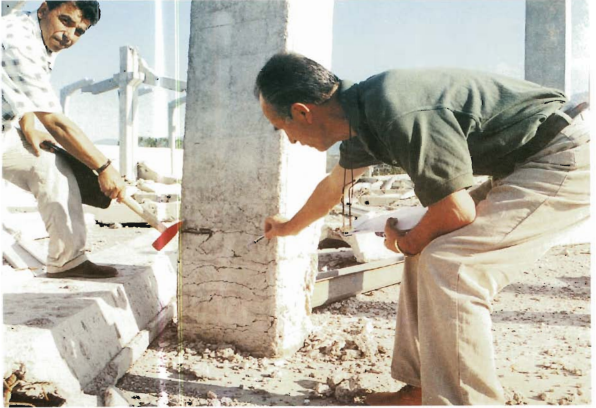
SANDIK TEMEL ANKASTRE KOLON TABANINDA EĞİLME MOMENTİ KIRILMASI, MAFSALLAŞMA
