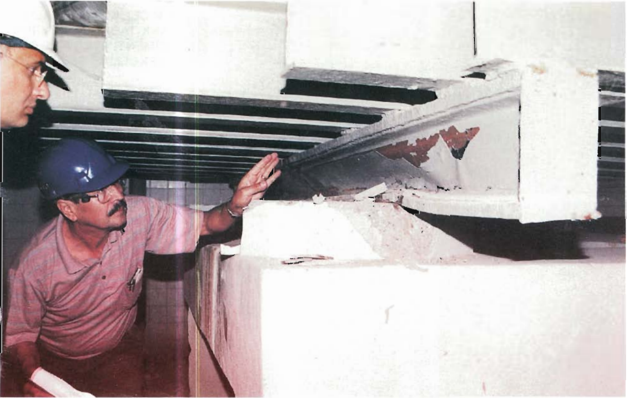
BİR ÇELİK TANKIN ALTINDA TANKIN TABANDA DEVRİLME MOMENTİ ETKİSİ İLE GÖVDESİ BURKULMUŞ ÇELİK PROFİLLER
