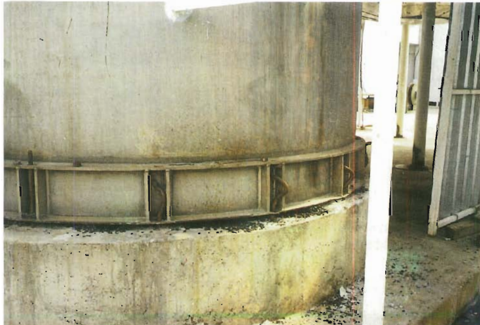
DEVRİLME MOMENTİ İLE ANKRAJ BULONUNDA SOMUNLAR SIYRILIR VE BULONLAR ÇELİK KUŞAK- TAKİ DELİKLERDEN GEÇERKEN BURKULUR
