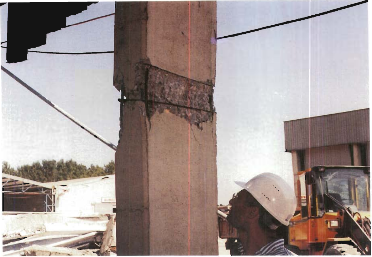
PREFABRİKE KOLONDA BOYUNA DONATININ YARIYA İNDİĞİ YERDE EĞİLME KIRILMASI (KARTONSAN KULLAR)
