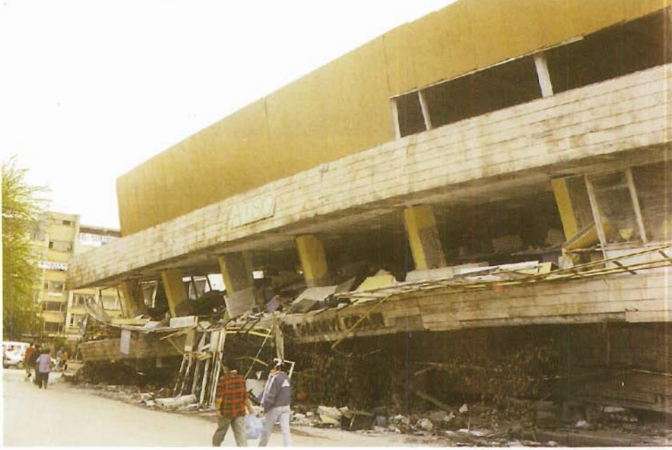
ADAPAZARI TİCARET VE SANAYİ ODASI VALİLİĞİN HEMEN YANINDA. GENİŞ AÇIKLIKLI VE AĞIR DÖŞEME PERDESİZ
