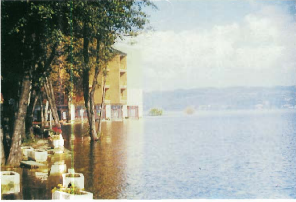
Sapanca Gölü güneyinde yanal yayılmalar nedeniyle göl içine kaymış yapı (Sapanca Oteli).
