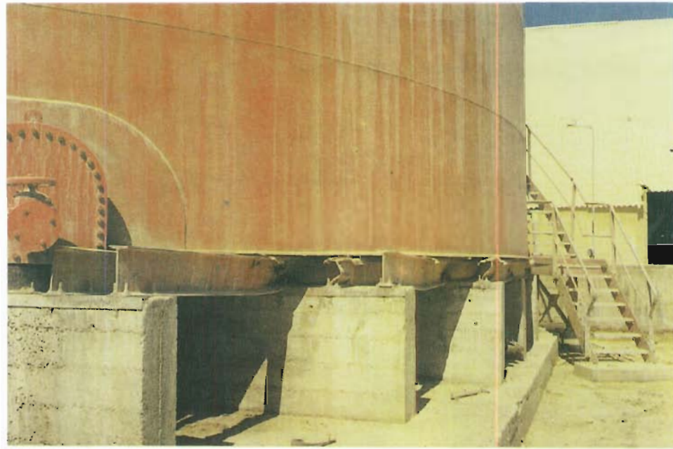
BİR ÇELİK TANKIN ALTINDA TANK TABANDA DEVRİLME MOMENTİ ETKİSİ İLE GÖVDESİ BURKULMUŞ ÇELİK PROFİLLER
