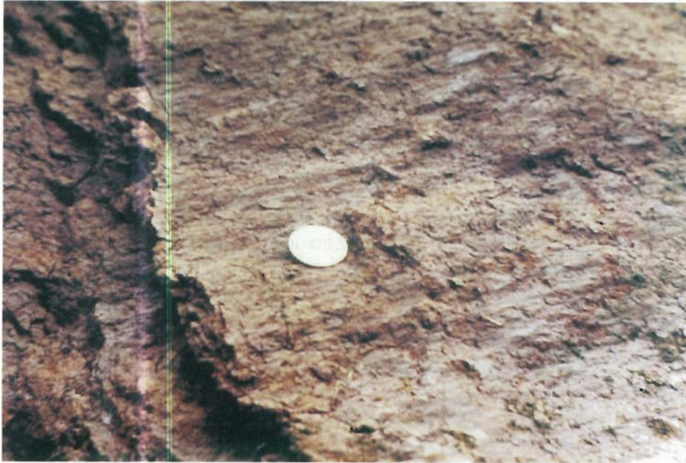
Hendek duvarında killi birimde 1999 depremine ait kayma çizikleri.
