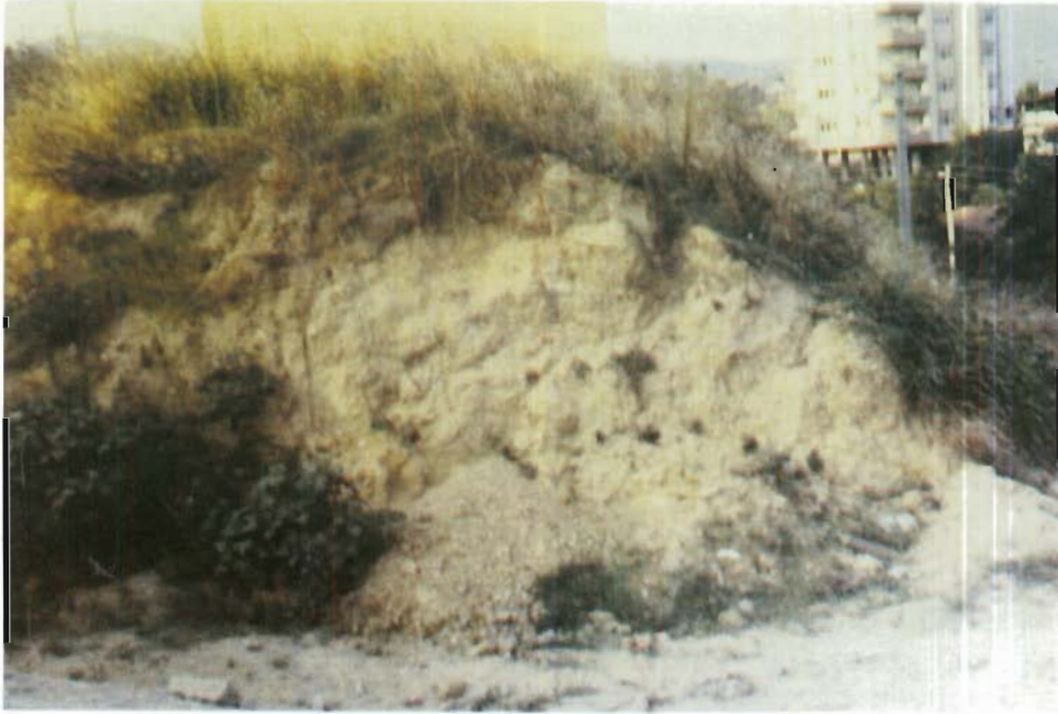
İzmit Altmışevler'de temel için açılmış bir yarma (killi zemin).
