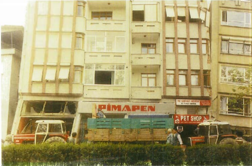
ADAPAZIRINDA ZEMİN KATINDA YÜKSEK DÜKKAN BOŞLUĞU NEDENİ İLE ÇOK BÜYÜK MİKTARDA ÖTELENMİŞ YAPI
