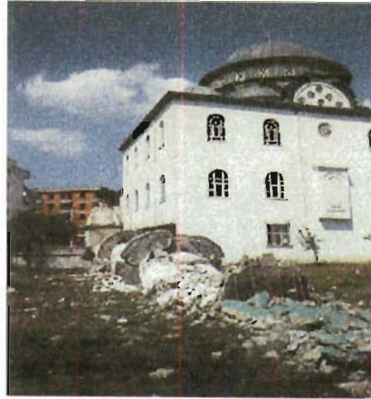
Şekil 10. Şekil 9'da yerleri verilen cami mineralleri hasarı.
