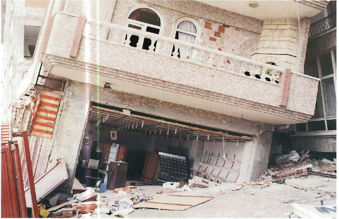
ADAPAZARI'NDA SIVILAŞMA NEDENİ İLE TAŞIMA GÜCÜNÜ YİTİRMİŞ ZEMİNDE YAN YATAN VE DEVRİLEN YAPILAR
