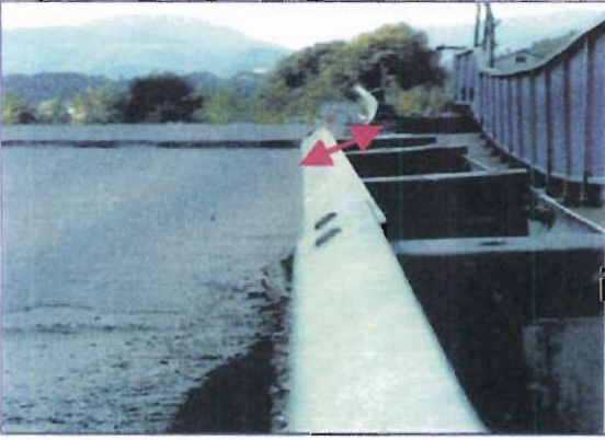
Otoban üzerinden geçen Arifiye Köprüsü (40.42.57N-30.21.45E)
