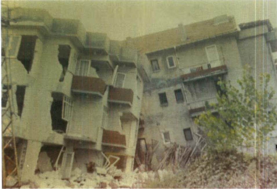
İzmit'güneydoğusunda sivilaşma nedeniyle yan yatmış yapılar.
