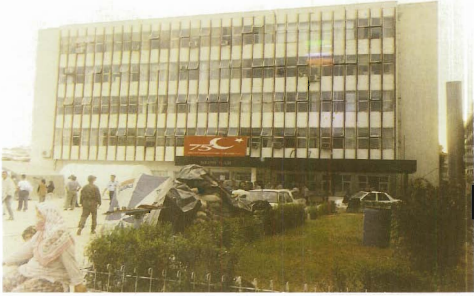
1967 DEPREMİNDE HASAR GÖRÜP ONARILMIŞ SAKARYA VALİLİK BİNASI BU DEPREMDE HASARSIZ
