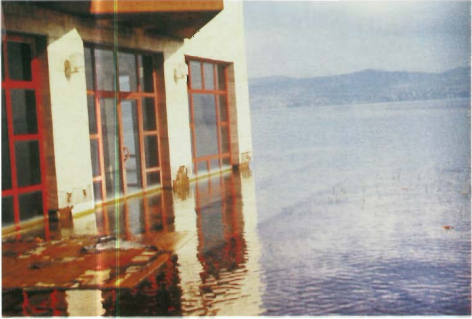
Sapanca Gölü güneyinde yanal yayılmalar nedeniyle göl içine kaymış yapı (Sapanca Oteli).
