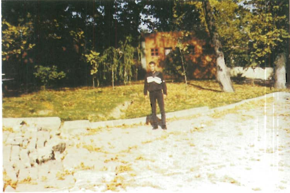
Sapancü Gölü güneyinde kum kaynamaları ve yanıl yayılmalar.
