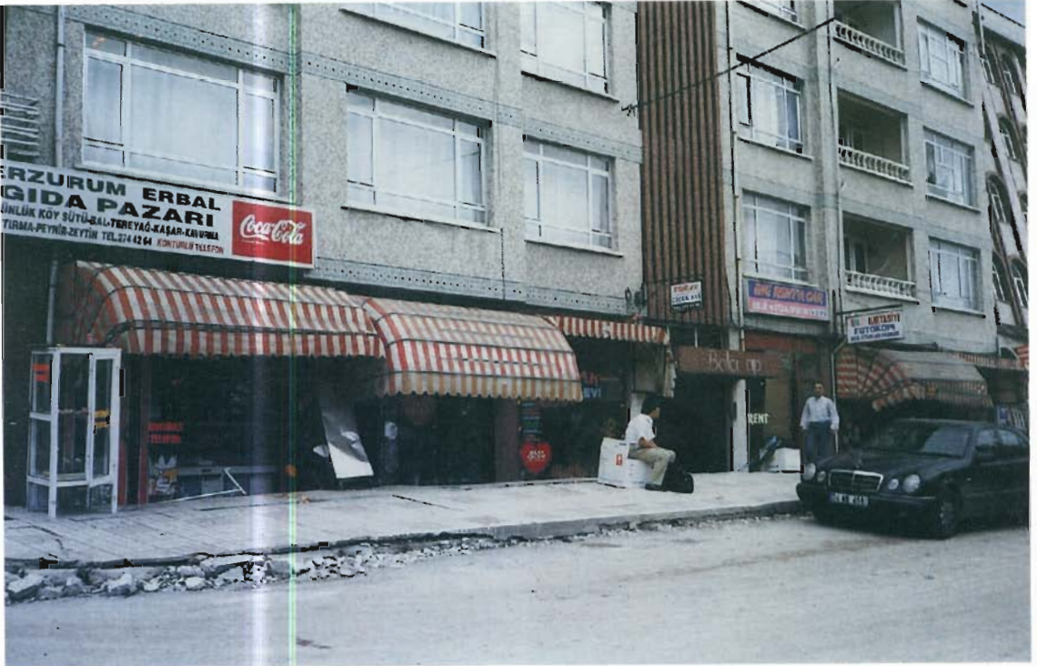
Adapazarı'nda sivilaşma nedeniyle zemin katları gömülmüş yapılar.
