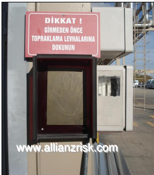
Resim 12 Topraklama levhası
