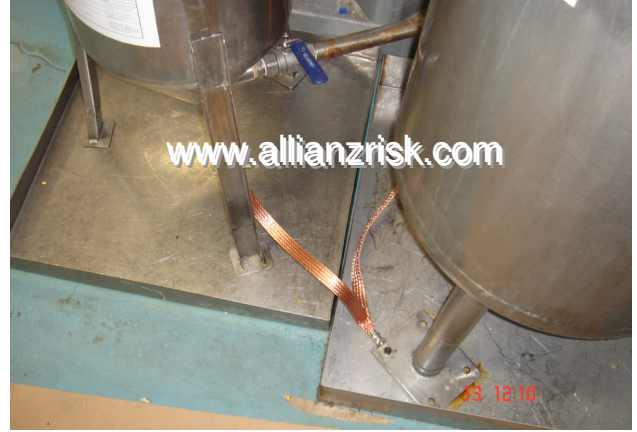
Resim 9 Bonding (eş potansiyel bağlantısı yapılmış tanklar)
