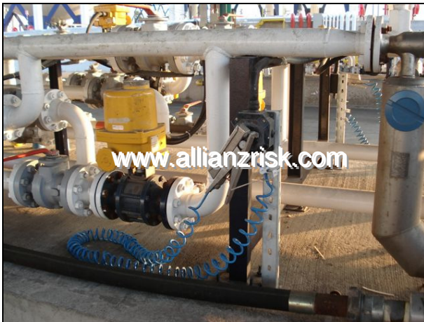
Resim 8 Dolum sırasında yapılan seygar topraklama
