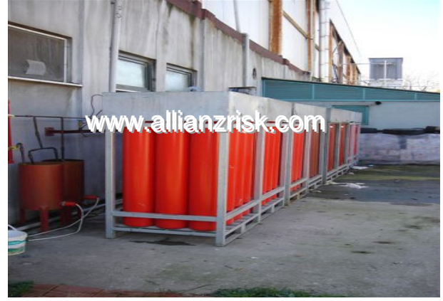
Resim 19 Basıncı tüp depolaması
