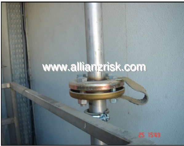
Resim 7 Eş potansiyel bağlantısı
