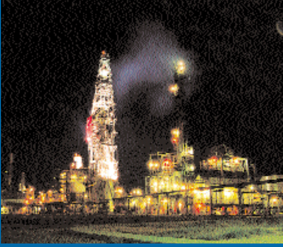
1955 – Güneydoğu Anadolu Bölgesi'nde Türkiye'nin ilk modern petrol rafinerisi olan Batman Rafinerisi devreye alındı. 1955 – The Batman Refinery, the first modern refinery of Turkey was commissioned in the South-east Anatolia Region.
