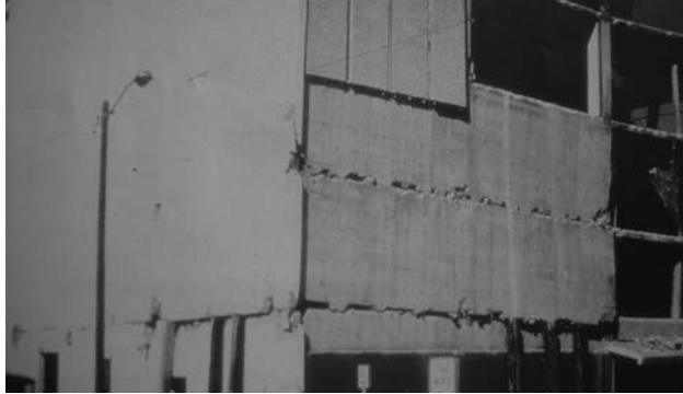
Fotoğraf 6. Betonarme Perde Üzerine Kaplama
