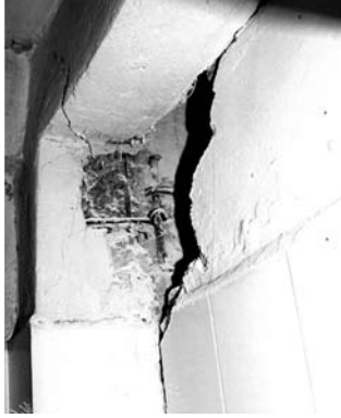
Fotoğraf 7. Kolonda Kayma Kırılması (Kaynak: Afet İşleri Genel Müdürlüğü Arşivi)
