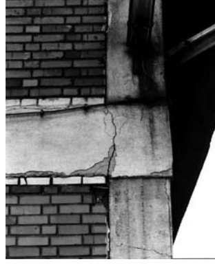
Fotoğraf 8. Eğilme Kırılmaları Seyrek Etriye (Kaynak: Afet İşleri Genel Müdürlüğü Arşivi)
