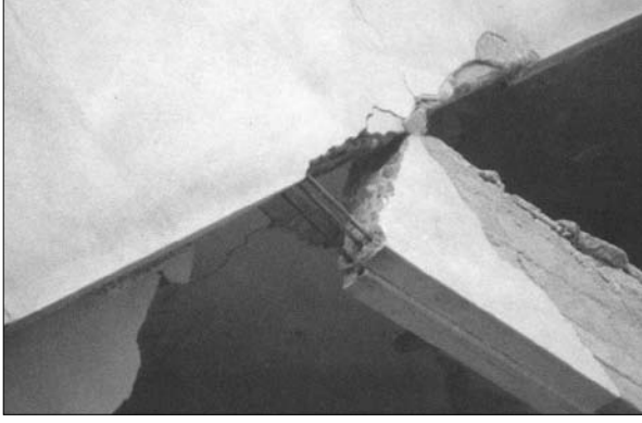
Fotoğraf III. Zayıf Kolon-Güçlü Kiriş, Yetersiz Aderans (Kaynak: Afet İşleri Genel Müdürlüğü Arşivi)
