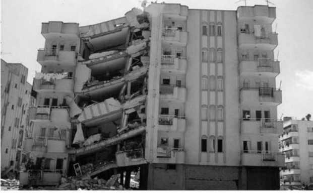
Fotoğraf 11. Yumuşak Kat ve Burulma Etkisiyle Tek Tarafa Çökme (Kaynak: Afet İşleri Genel Müdürlüğü Arşivi)
