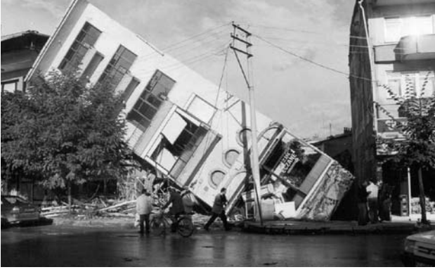
Fotoğraf 10. Sıvılaşma ve Şiğ Temelin Neden Olduğu Devrilme (Kaynak: Afet İşleri Genel Müdürlüğü Arşivi)
