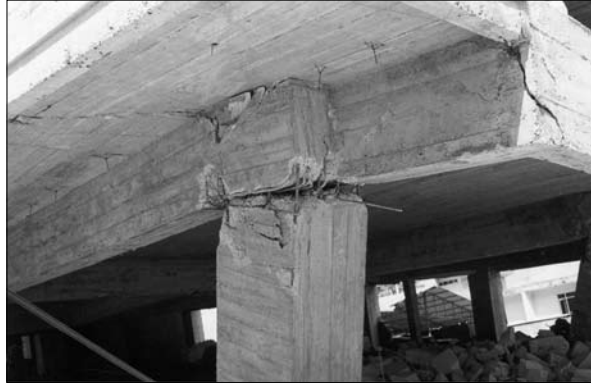
Fotoğraf II. Zayıf Kolon-Güçlü Kiriş Bağlantısı (Kaynak: Afet İşleri Genel Müdürlüğü Arşivi)
